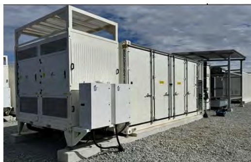
Containers batteries avec transformateur et toiture technique
