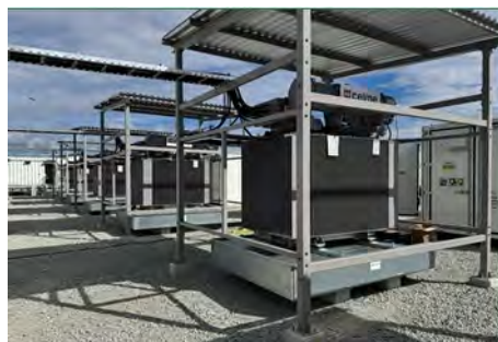
Containers batteries avec transformateur et toiture technique
